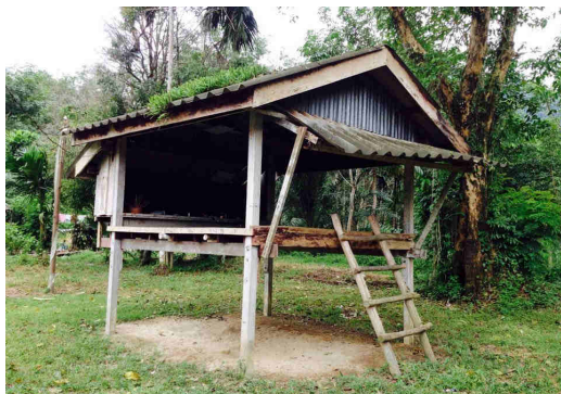
๗. โครงการก่อสร้างศาลาพิธีกรรมชาวไทยใหม่ บ้านขนิม หมู่ที่ ๗
