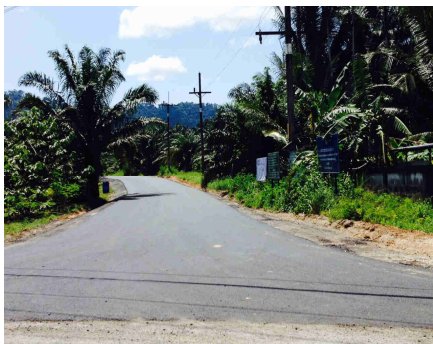
๖. โครงการก่อสร้างถนนแอสฟัลติกส์สายบางปอ บ้านอินทนิล หมู่ที่ ๖
